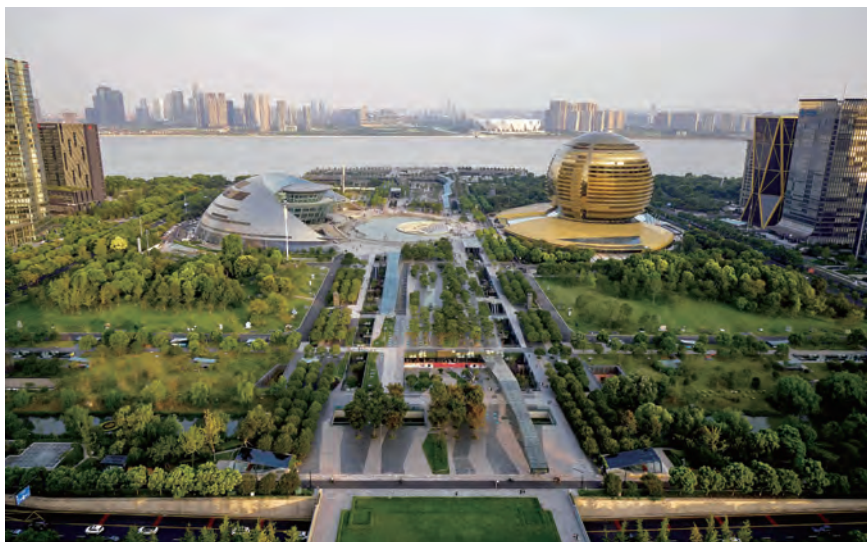
杭州钱江新城两翼城市二号阳台景观工程
