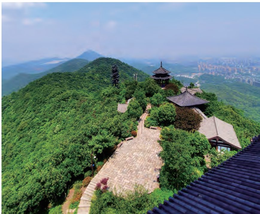
滨江市政园林承建的半山公园
